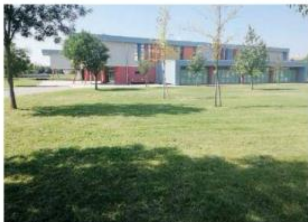
La struttura. Una veduta della scuola di via Falcone
