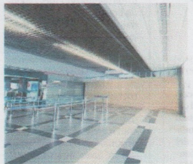
Lavori. Al via le opere di demolizione
