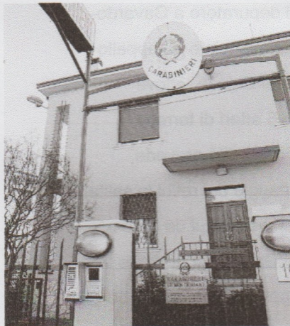
Carabinieri. L'attuale caserma è ormai inadeguata
