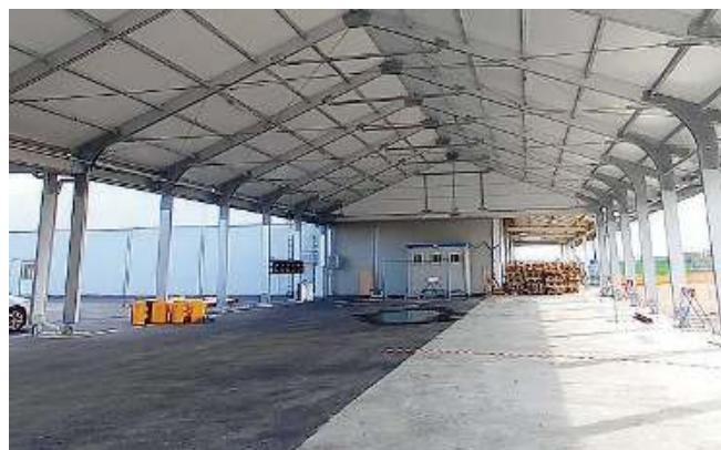
Le pensiline. L'area di carico e scarico della merce
