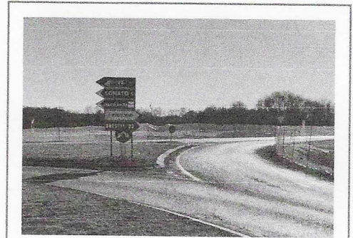
Montichiari La recinzione piazzata a protezione dell'area interessata dal cantiere della variante
