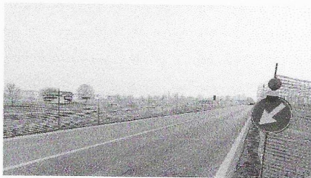
Il cantiere. Lavori in corso per la realizzazione della Tangenziale Est
