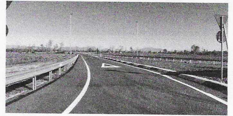
Montichiari Uno sguardo sulla Variante Est che libererà il centro dal traffico di passaggio
